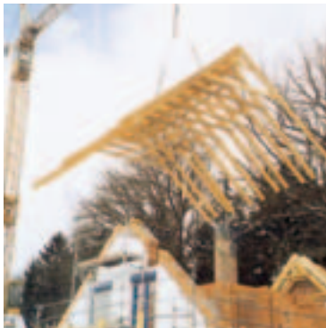
b Abbau des alten Dachstuhls komplett am Stück
