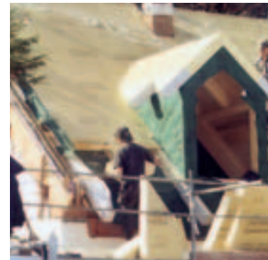
d Dachschalung und Außen-Wärmedämmung
