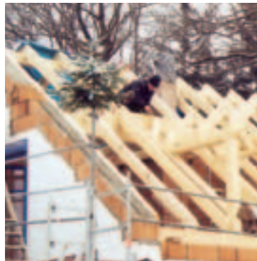
c Neuer Dachstuhl mit sichtbaren Balken.
