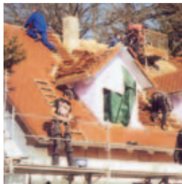
f Dacheindeckung mit Biberschwanz-Dachziegeln
