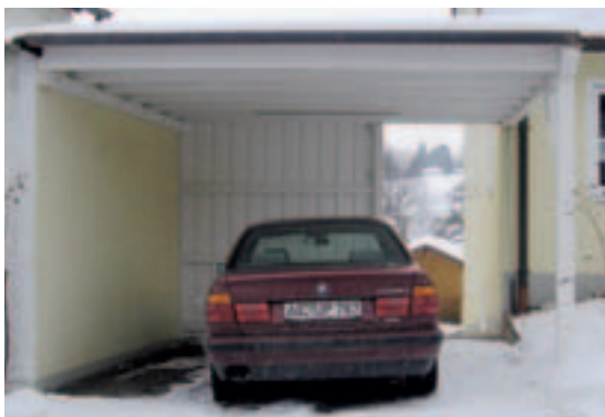
Carport mit Dach, montiert an die bereits vorhandene Garage.
