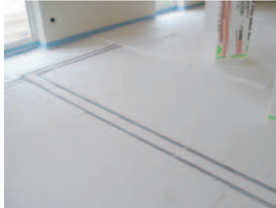
Dämmen: Trittschall- und Wärmedämmung
