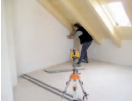
Ausmessen: Exaktes Vermessen mit moderner Lasertechnik
