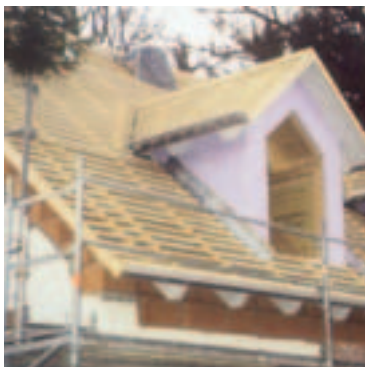
e Dachlattung und Dämmung der Dachgauben
