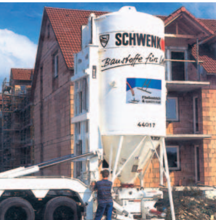
Anhydrit-Fließestrich verteilen: z.B. über einen Schlauch aus einer Fördermischpumpe (siehe Abb. unten)
