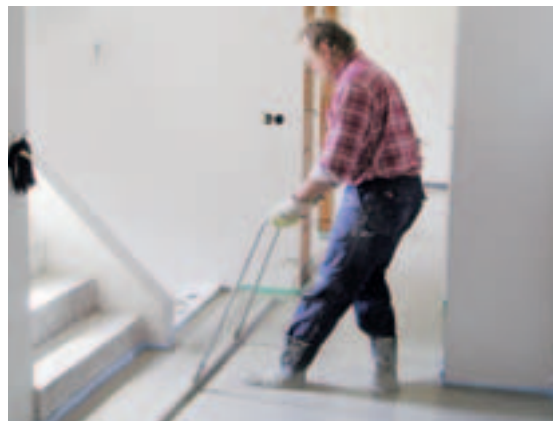
Egalisieren: Der Boden muß für den späteren Bodenbelag exakt im Wasser sein und eine glatte Oberfläche bieten.
