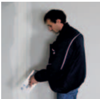
Um spätere Risse zu vermeiden, ist die saubere Ausführung der Spachtelarbeiten besonders wichtig.
