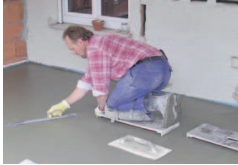
Robert Palleis, Inhaber von L&P Estrichbau beim Glätten eines Zementestrichs
