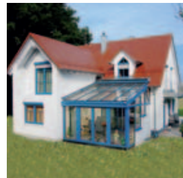
g Ergebnis nach dem Um- und Ausbau
