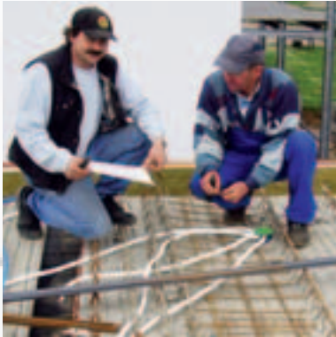
Installationsarbeiten an einer Geschoßdecke nach genauen Plänen
